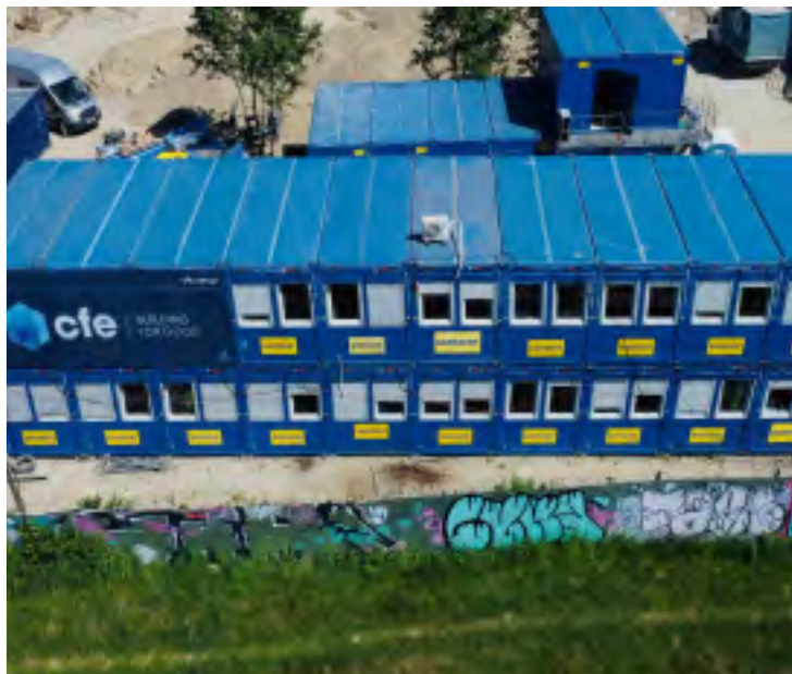
Budowa Designer Outlet Kraków
