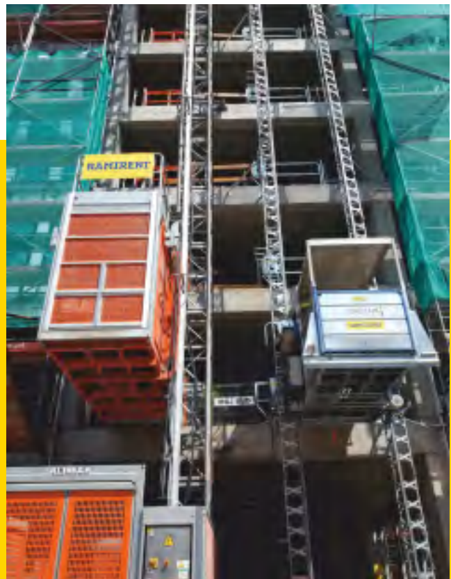
Budowa biurowca F2F w Katowicach, windy ALIMAK SCANDO 650 i GEDA 1500 Z/ZP-2
