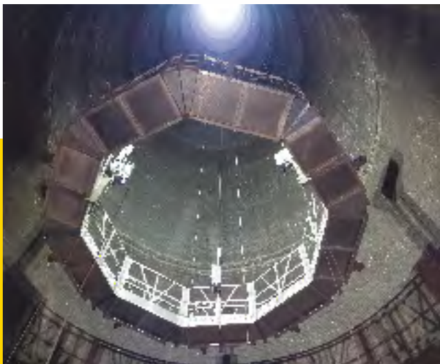
Remont kominy H=120 Elektrociepłowni Skawina, konstrukcja podestu na bazie GEDA AB 650
